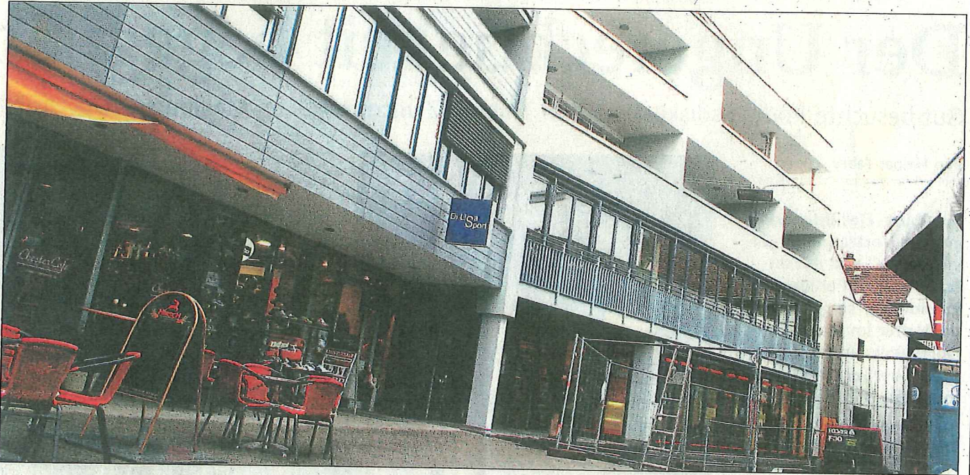
Das neue Wohn- und Geschäftshaus Chesterplatz 4 (rechts)
