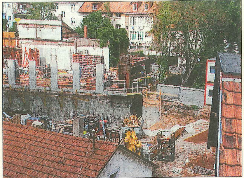
Drei Projekte werden auf der Großbaustelle Hirschenareal realisiert. Vor wenigen Tagen wurden die vorbereitenden Arbeiten für den Bau des an Karstadt angelehnten Hochhauses eingeleitet. FOTO: HORST DONNER
